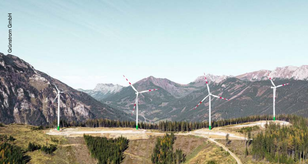
Der Windpark Silbersberg wurde im November fertiggestellt: Jahresproduktion rund 28 Mio. kWh.
