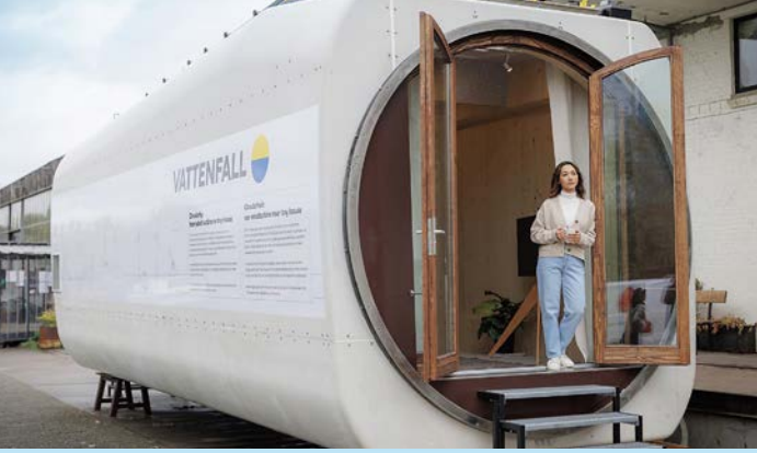
Das „Wind-Tiny-House“ aus dem Maschinenhaus einer Windkraftanlage aus Gols ist 4 Meter breit, 10 Meter lang und 3 Meter hoch.
